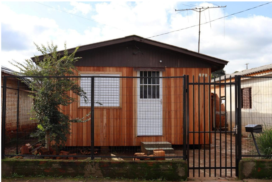
Imagem 1: Edificação em vistoria em Setembro 2025
