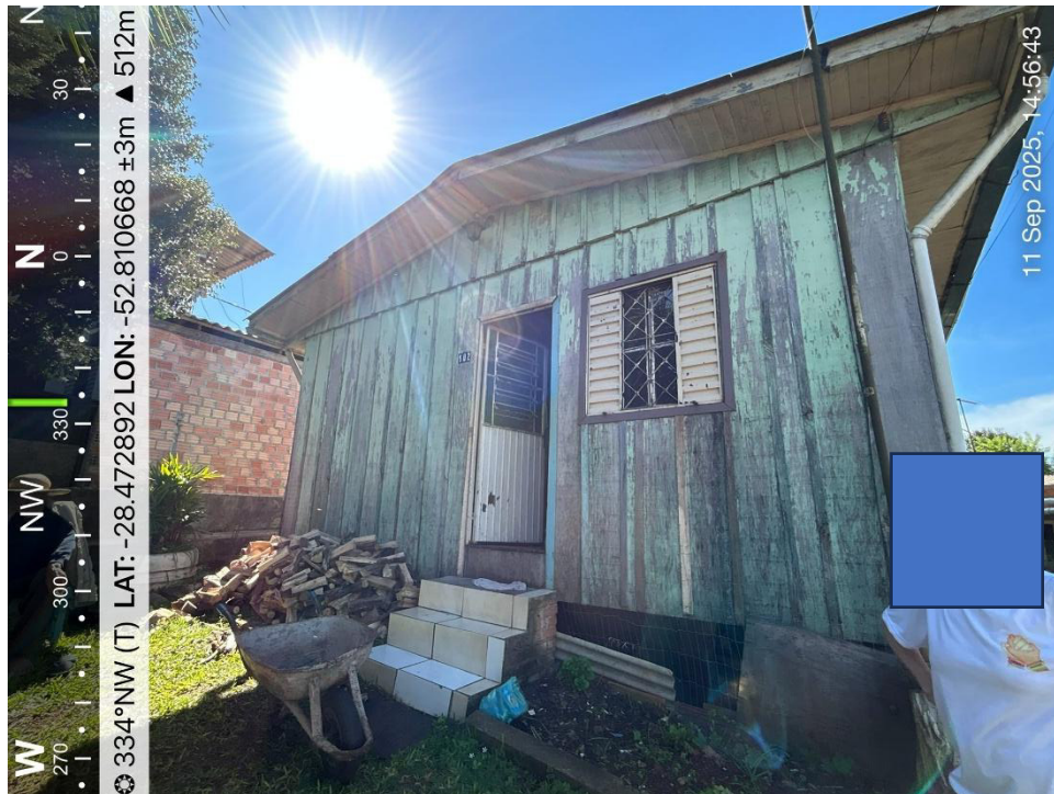
Imagem 1: Edificação em vistoria em Setembro 2025
