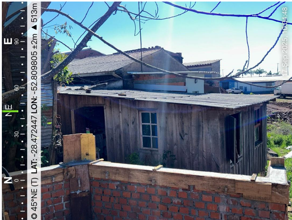
Imagem 1: Edificação em vistoria em Setembro 2025
