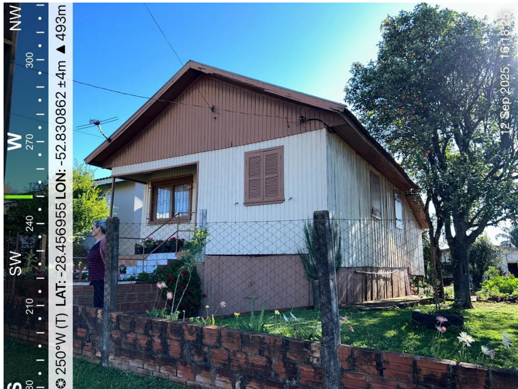
Imagem 1: Edificação em vistoria em Setembro 2025
