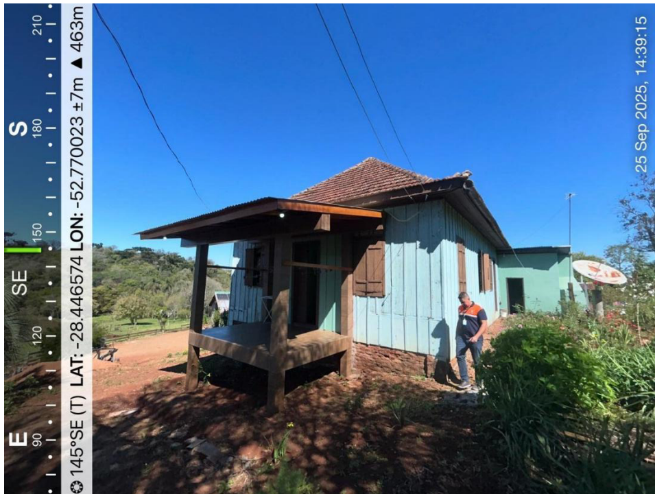
Imagem 1: Edificação em vistoria em Setembro 2025
