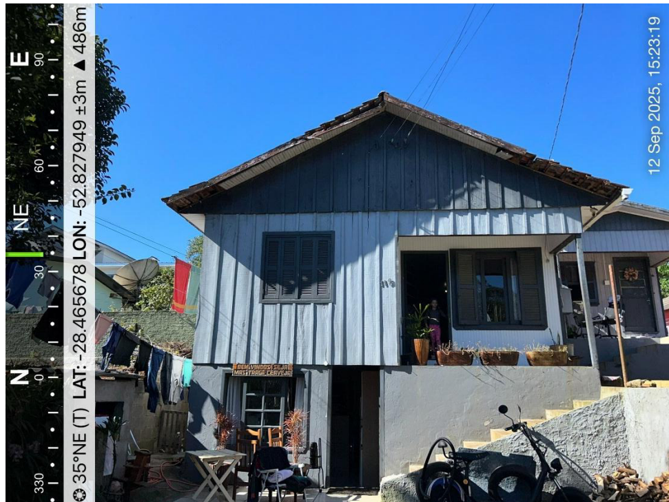
Imagem 1: Edificação em vistoria em Setembro 2025
