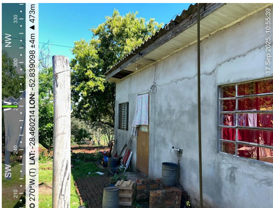
Imagem 1: Edificação em vistoria em Setembro 2025
