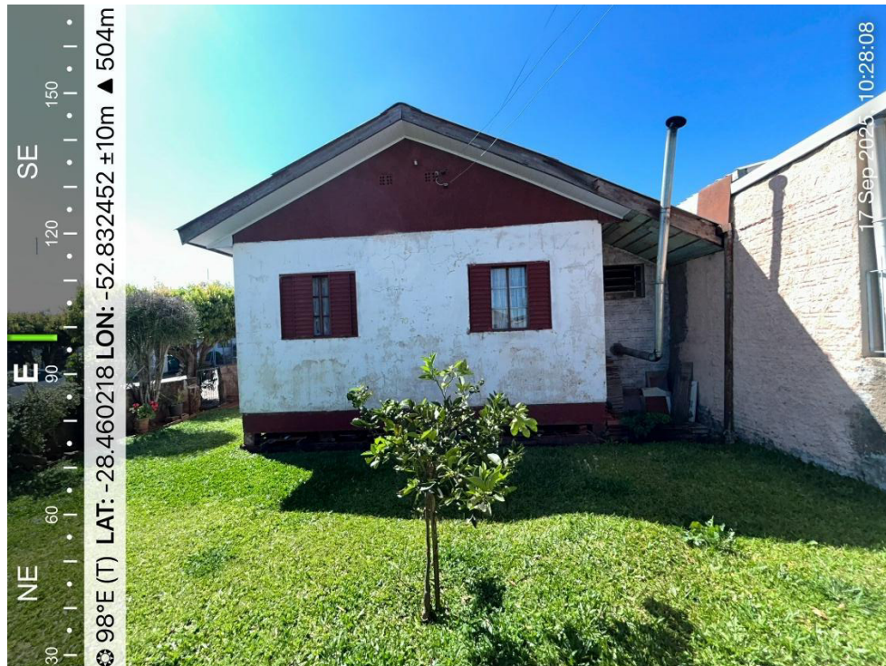
Imagem 1: Edificação em vistoria em Setembro 2025
