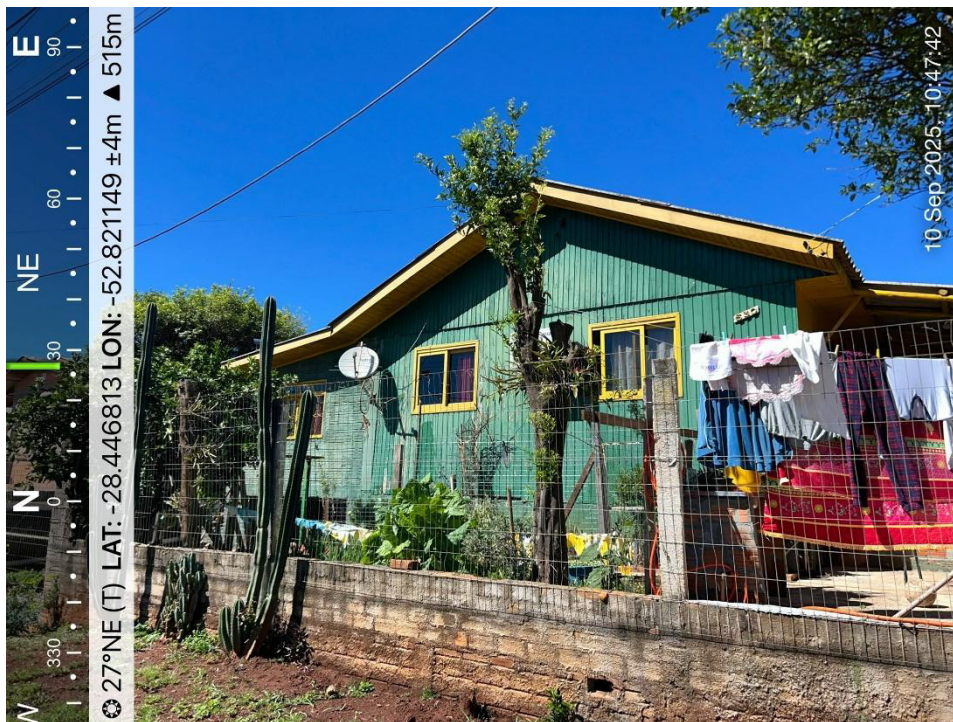
Imagem 1: Edificação em vistoria em Setembro 2025
