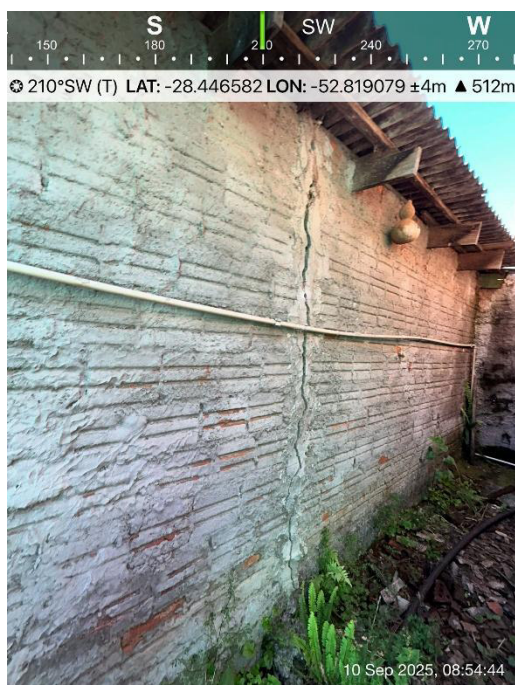
Imagem 4 e 5: Rachadura no encontro de paredes
