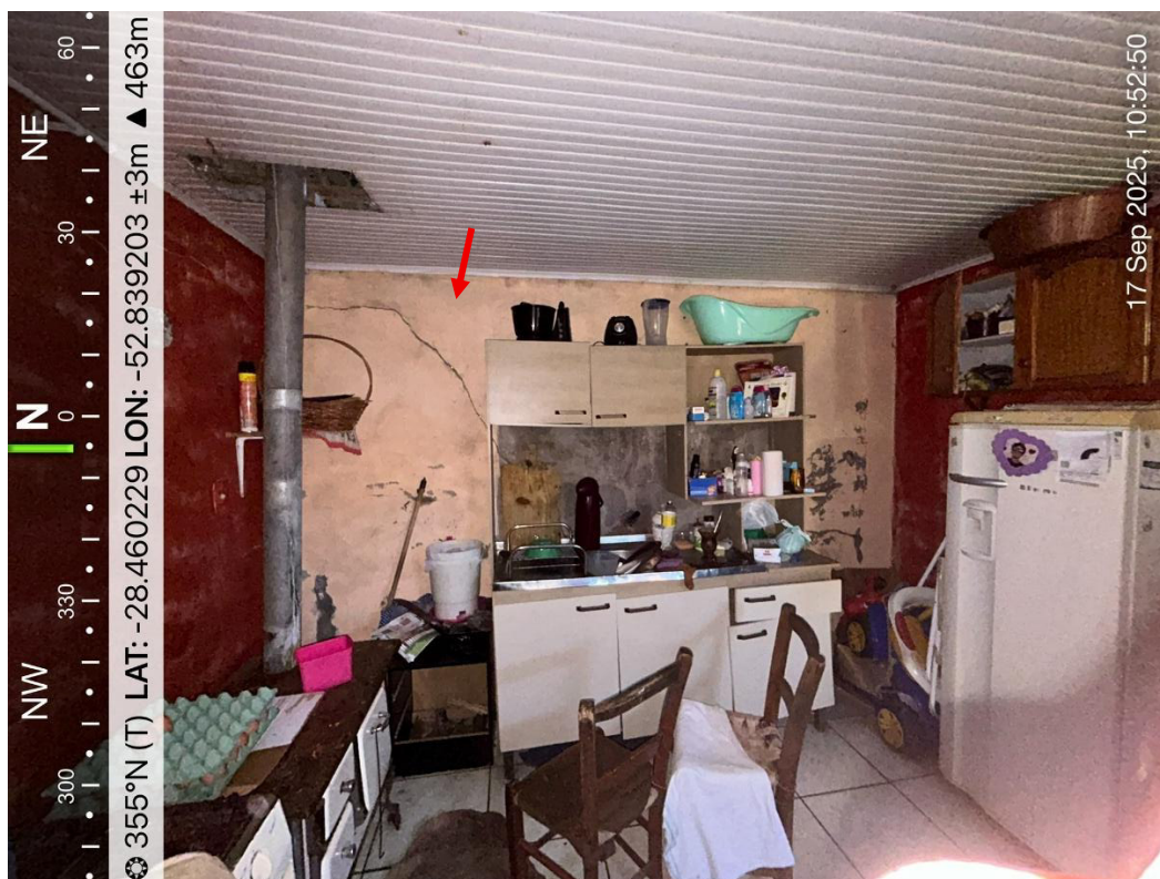
Imagem 2: Edificação em vistoria em Setembro 2025
