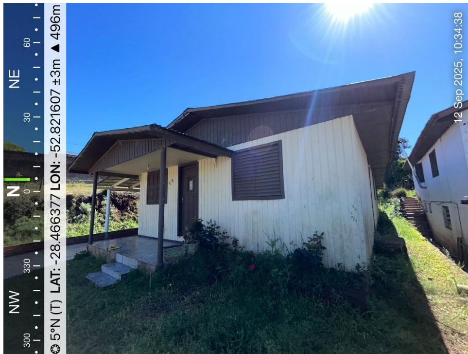
Imagem 1: Edificação em vistoria em Setembro 2025
