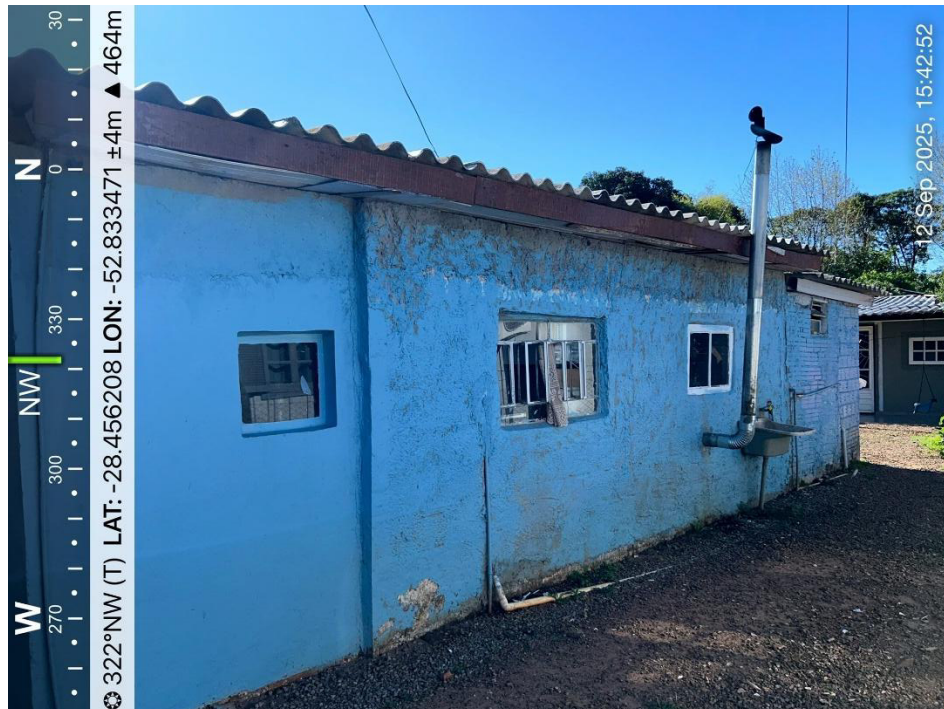
Imagem 1: Edificação em vistoria em Setembro 2025
