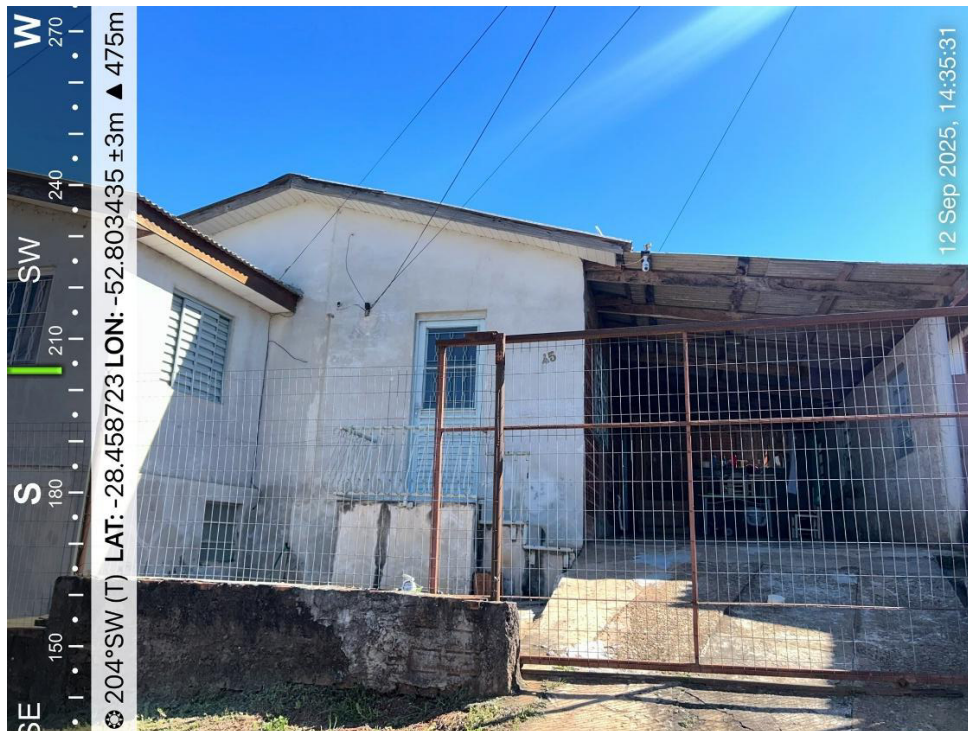
Imagem 1: Edificação em vistoria em Setembro 2025
