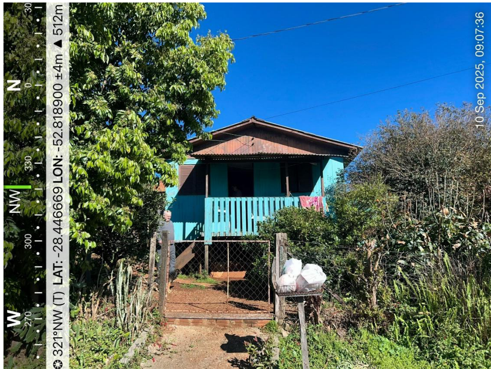
Imagem 1: Edificação em vistoria em Setembro 2025
