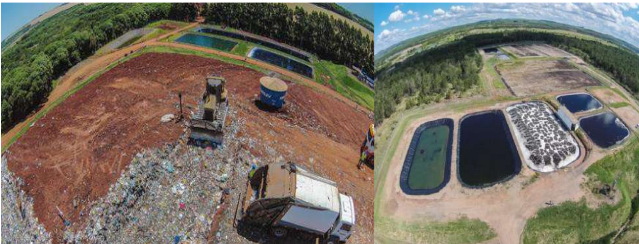
Figuras 27 e 28. Célula em operação e estação de tratamento de efluentes (chorume)
