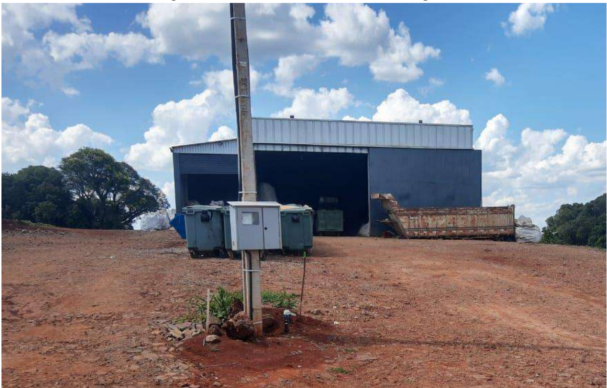
Figura 20. Central de transbordo e triagem
