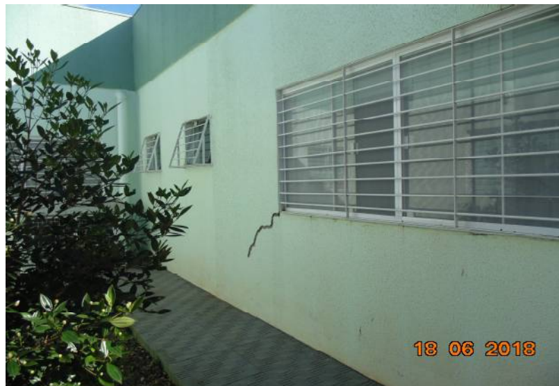
Figura 4: Corrigir fissura externa.
