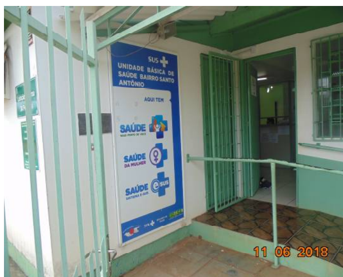
Figura 2: Portas de acesso.
