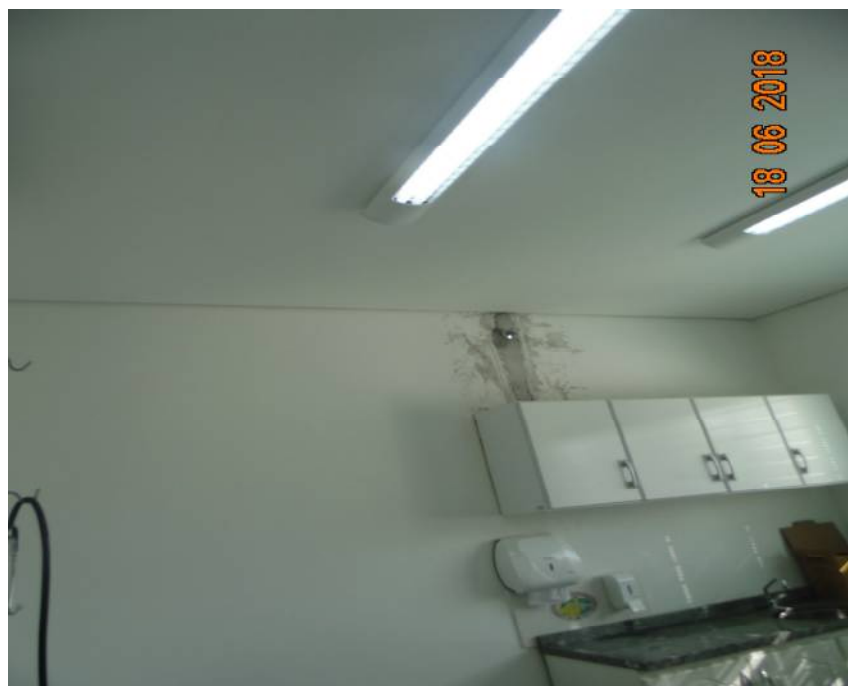
Figura 7: Aplicar massa corrida e pintura na parede onde foi substituído registro.
