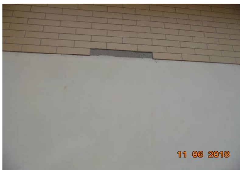
Figura 4: Recolocar 2 peças cerâmicas na fachada principal.
